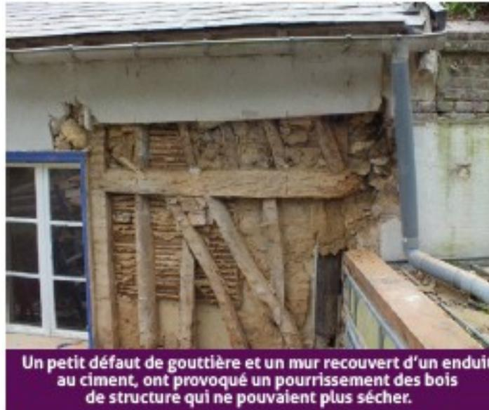
Un petit défaut de gouttière et un mur recouvert d'un enduit au ciment, ont provoqué un pourrissement des bois de structure qui ne pouvaient plus sécher.
