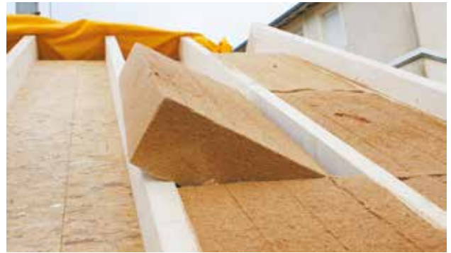
La laine de bois est utilisée dans la fabrication d'isolants pour le toit et les murs.
