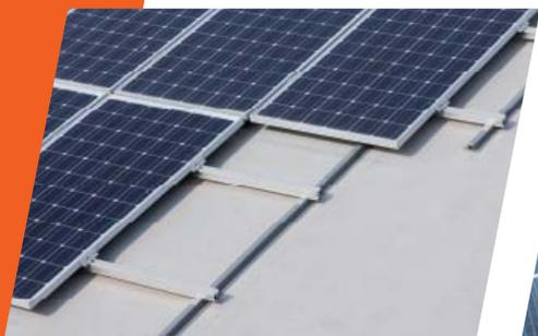
*Système liaisonné à l'étanchéité*
