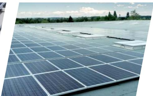
*Système liaisonné à l'étanchéité*
