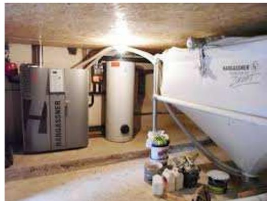
**Figure 11 : Chaudière à granulés**
