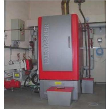
**Figure 12: Chaudière à plaquettes**
