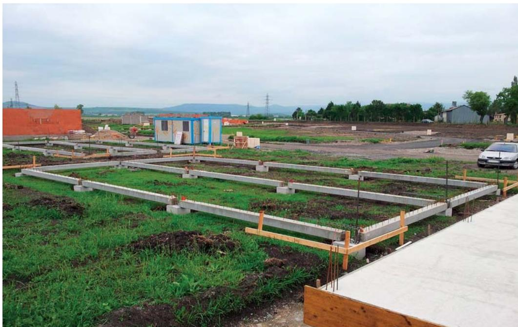
Les longrines sont des éléments généralement préfabriqués suivant les prescriptions techniques des bureaux d'études béton armé ; elles permettent :
