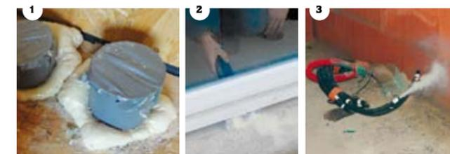
1. Traversées de parois non soignées (© CO2 Conseil) - 2. Installation de coulisants « classiques » (© Air Vision) - 3. Tableau électrique dans volume non chauffé (© Air Vision)
