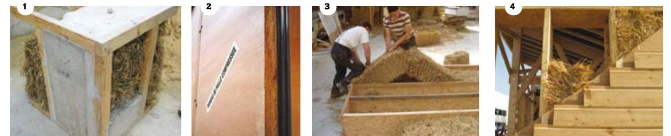
1. Technique du GREB - 2. Panneau de paille compressée STRAMIT ® - 3/4. Technique « Caissons préfabriqués » © C. Desmichelle & C. Natali
