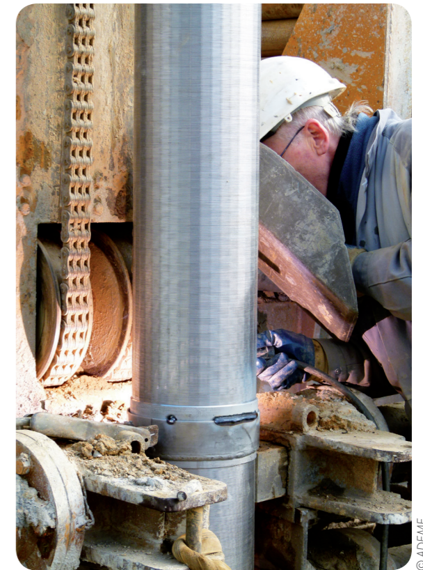
Mise en place d'un puits géothermique pour PAC sur EST
