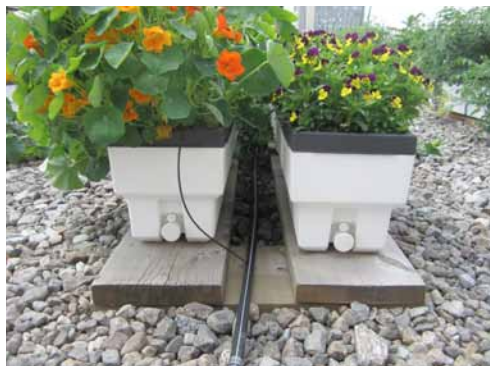
Protection en bois sur toiture inversée.
