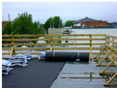
Protection en panneau de drainage (Sopradrain 10G) sur membrane élastomère.
