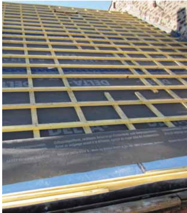
Refonte de la toiture avec pare-pluie HPV, contre-litonnage, litonnage et nouvelle tuile avec tuile faitière ventilé.
