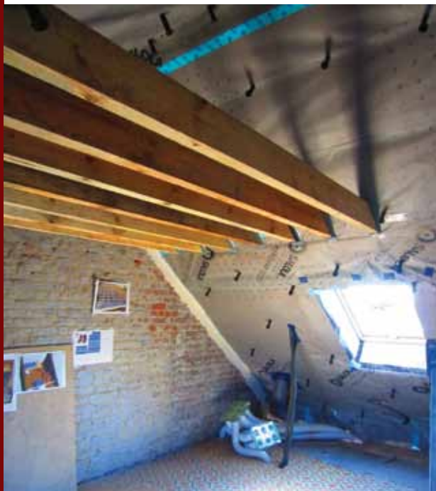
Mise en étanchéité parfaite entre les fenêtres de toit, les poutres mezzanine, les murs et autres passages de gaines (solaire thermique, VMC)
