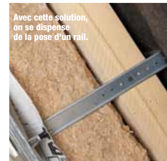
e) Equerre Sixbox® + membrane + Sixbox® + fourrure (vide technique 15 mm à 100 mm)
