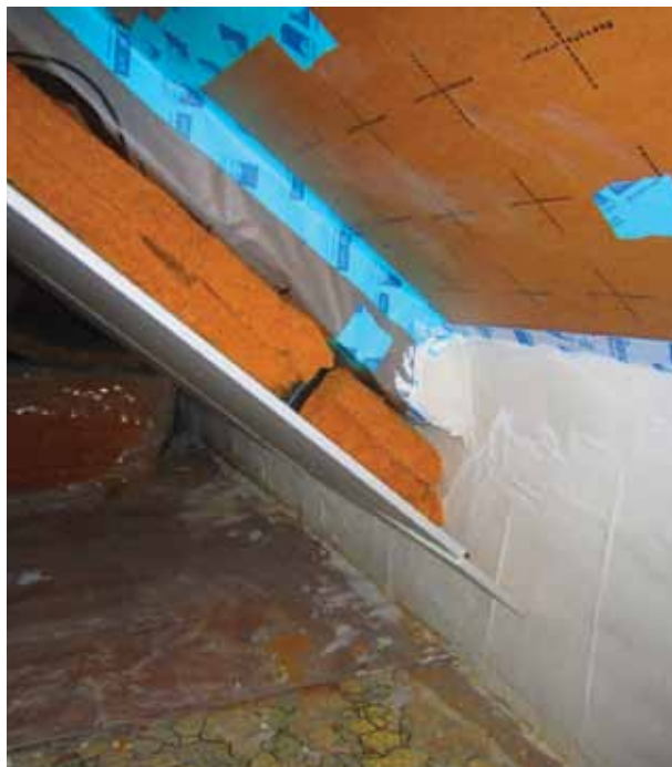
Petit détail important ! Mise en place au dessus de la trémie de l'escalier à la place de la laine de bois, des plaques de polyuréthane afin de gagner de la place pour le passage tout en étant performant (18 cm MPU, R=8,2 )
