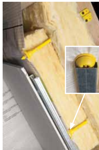
c) Optima 2® + membrane + fourrure (vide technique 15 mm) + parement
