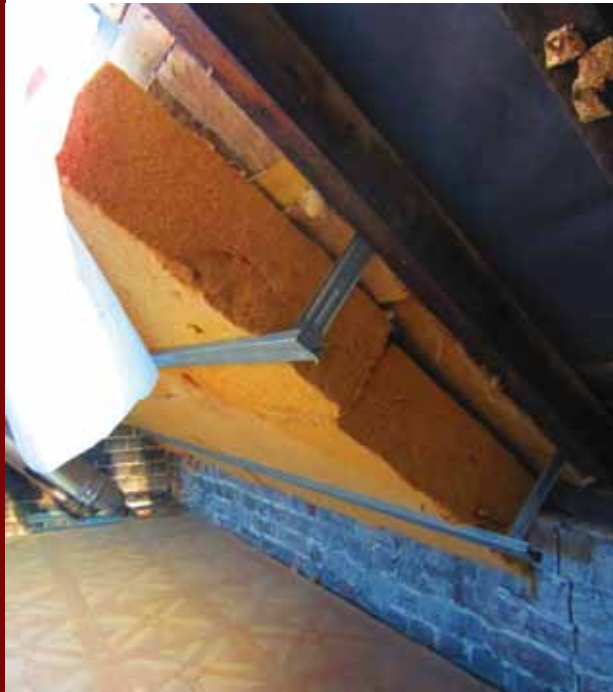
Mise en place de laine de bois (confort d'été), avec fourrure + suspente métallique, 8 cm entre chevrons + 16 cm en croisé... mais ce n'est pas fini !
