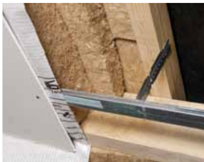
b) Suspente + fourrure + membrane (pas de vide technique) + parement
