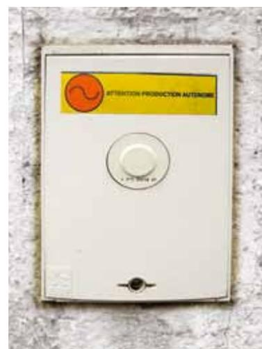
— À gauche : présence d'un onduleur signalée par les étiquettes normalisées
