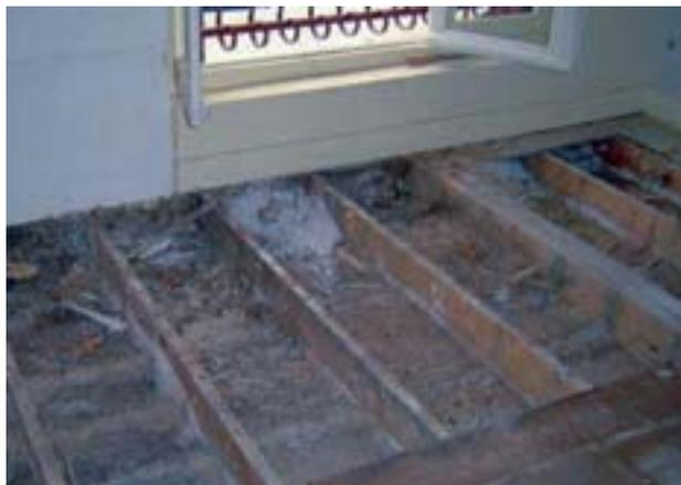
Constat d'un solivage sous-dimensionné (Source FFB-CMP)
