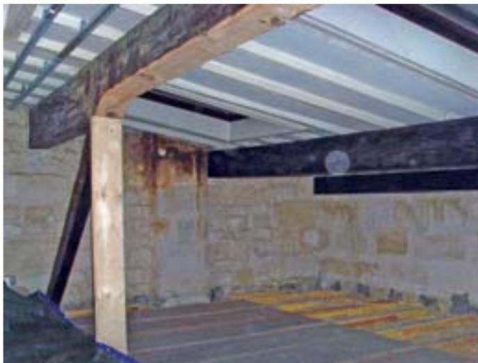
*Isolation et modification de la charpente existante (Source FCBA)*
