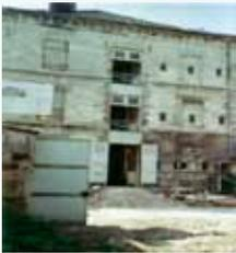
Un échafaudage de maçon est installé entre les parties à démolir et à conserver pour faciliter la manutention : les pierres sont prélevées et réinstallées au même niveau (pas d'engin).
