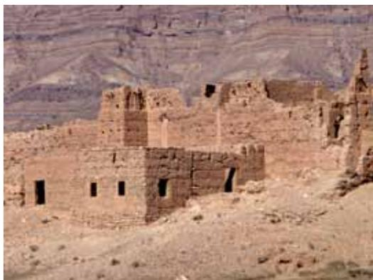
Murs en terre crue, planchers et toiture en poutres bois et cannes issues de cultures locales. Avantages : autoconstruction, matériaux locaux "gratuits", masse thermique, déphasage jour/nuit, régulation hygrométrique.
