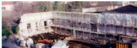
Le mur à démolir est utilisé comme carrière pour récupérer les blocs de craie et réparer les façades et la partie conservée du mur.
