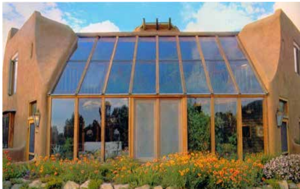
Maison construite en terre
