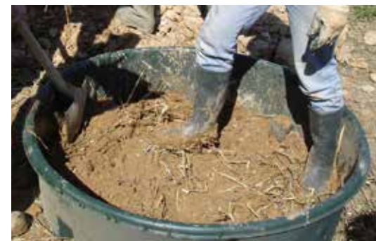
Mélange de terre crue et fibres végétales
