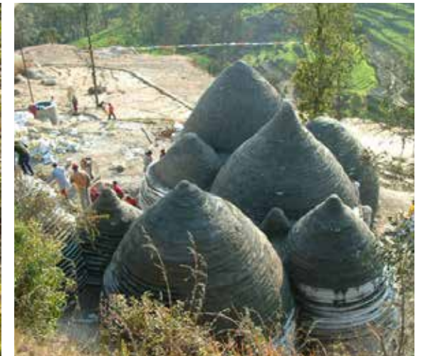
Construction en adobe empilé dans des sacs
