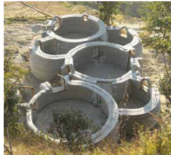
Construction en adobe empilé dans des sacs
