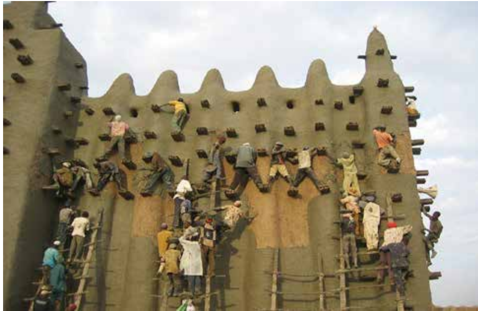
Construction d'une mosquée au Mali
