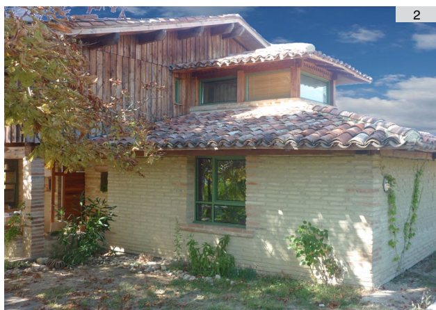
1. Chantier réhabilitation, 82 2. Maison D., 82, architecte : P. DELPRAT
