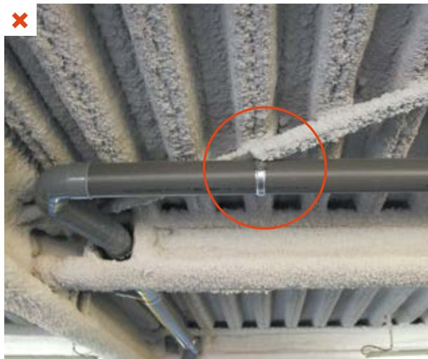
Collision entraînant la destruction du flocage du contreventement du plancher haut. ©AQC-2015
