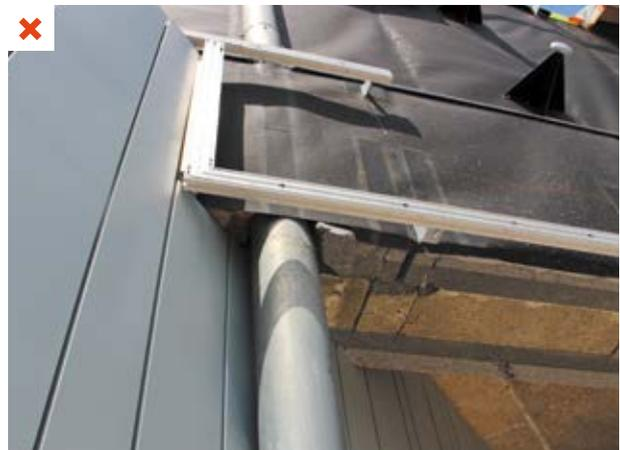
Descente d'eau pluviale traversant l'ITE. ©AQC-2015
