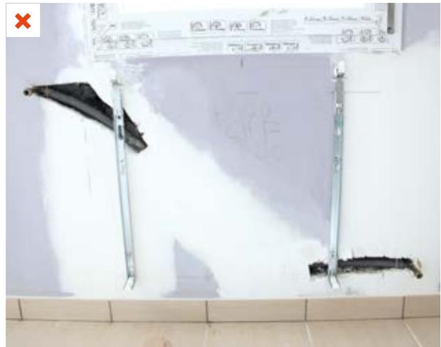
Adaptation de la longueur des tuyaux aux dimensions du nouveau radiateur permettant l'ouverture de la fenêtre. ©AQC-2015
