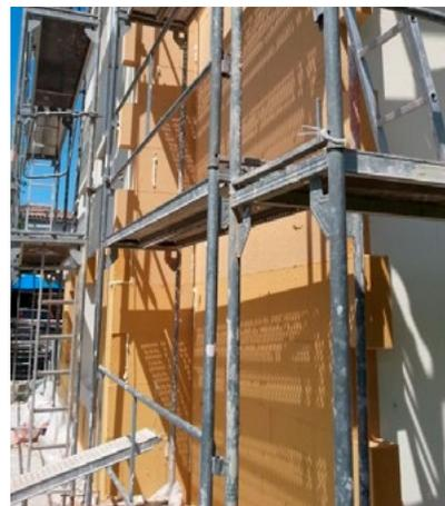
Pose d'une isolation par l'extérieur en fibre de bois rigide (couleur brune) qui sera recouverte d'une couche d'enduit à la chaux, lors de la rénovation thermique d'un bâtiment en béton.
