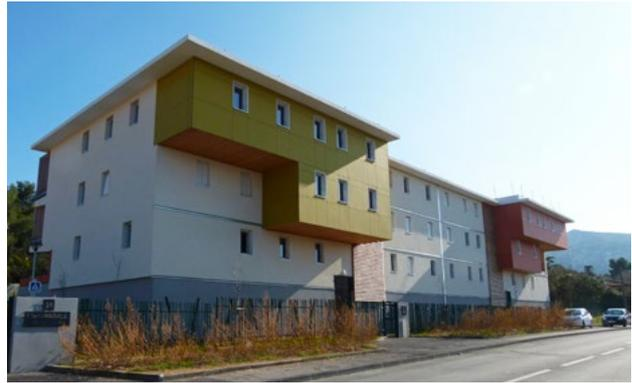
Éléments en surplomb insérés contre un immeuble en béton
