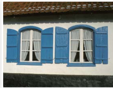
Henneveux, exemple de fenêtres cintrées
