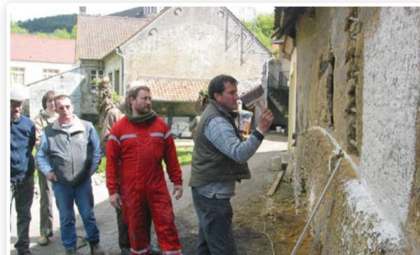
Pose de badigeon à la brosse
