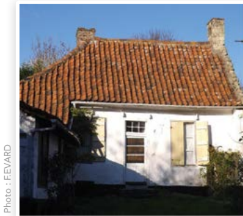
Guémy, pignon débordant maçonné
