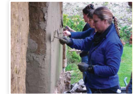
On pose l'enduit à la truelle, puis on le serre
