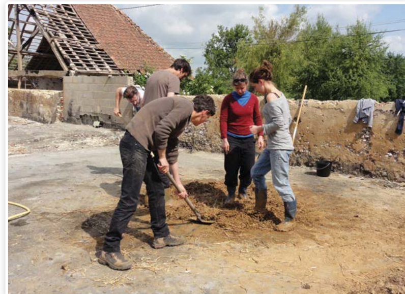
Foulage au pied du torchis. On appelle cette étape «la danse de l'artisan»
