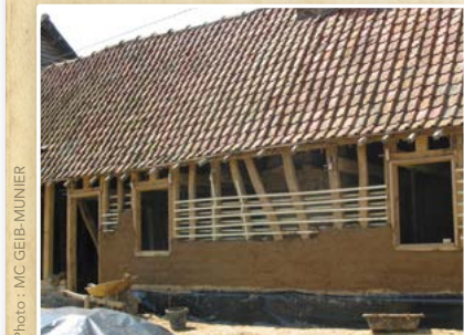
Charpente d'un mur gouttereau
