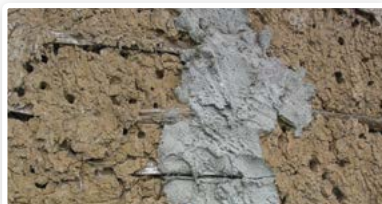
Reprise partielle en ciment, à purger
