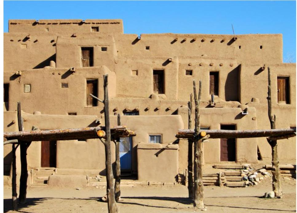
**Maçonnerie de briques de terre crue**
