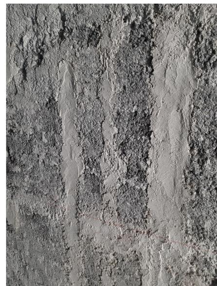
8. Comblement des saignées existante par un mortier chaux/chanvre/argile expansé
