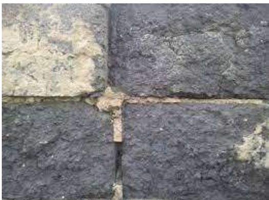
Figure 5. Blocs agglomérés de béton de mâchefer.
