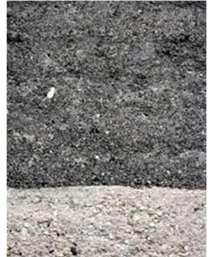
Figure 4. Mur en béton de mâchefer sur un soubassement en béton "classique".
