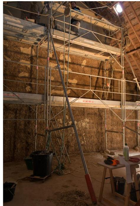
Une ossature en bois faite avec de grosses planches permettra de rentrer et de soutenir les bottes de paille qui doivent être bien comprimées en hauteur et en largeur.
