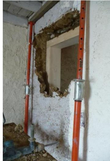
Cadre en bois installé, linteau rebouché et sec, début du percement de l'autre côté
