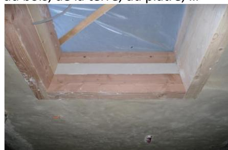
Remplissage en plâtre entre les 2 parties d'un cadre en bois
