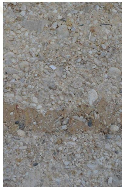
État de surface d'un mur en pisé sans bande stabilisé après 1 an de vie
