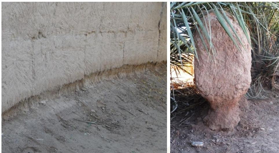
Mur en pisé attaqué par l'humidité permanente en bas de mur.
