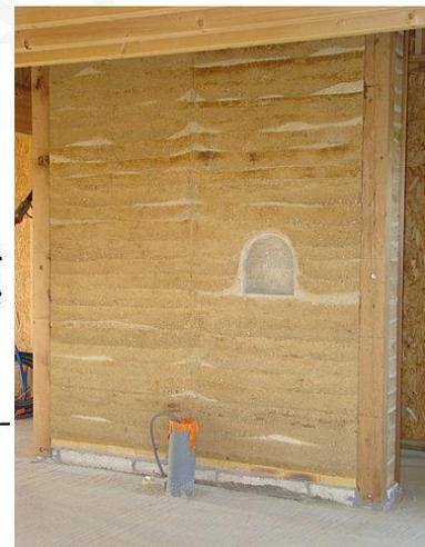
Les banches de faible hauteur posent plus de problèmes pour garder sa verticale que les banches hautes, puisqu'elles demandent plus de montage/démontage et qu'à chaque nouveau montage, les erreurs de verticalité se cumulent.
