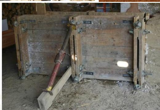
On peut monter aussi coffrer entièrement un côté du mur (banches verticales), et monter les banches horizontalement de l'autre côté du mur (côté qui nous sert à travailler). La verticale et la rectitude du mur sont réglées par les banches verticales.
