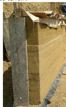
Chaînage vertical en béton armé
