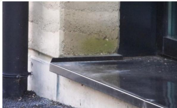
Pisé (légèrement stabilisé dans la masse) érodé au niveau du seuil d'une ouverture
