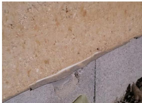
Soubassement en parpaings, pisé non stabilisé au dessus du film goudronné, érosion
