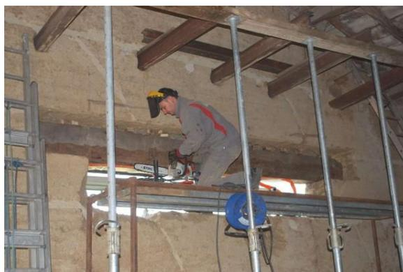
Percement du linteau côté intérieur, mise en place de la poutre, rebouchage
