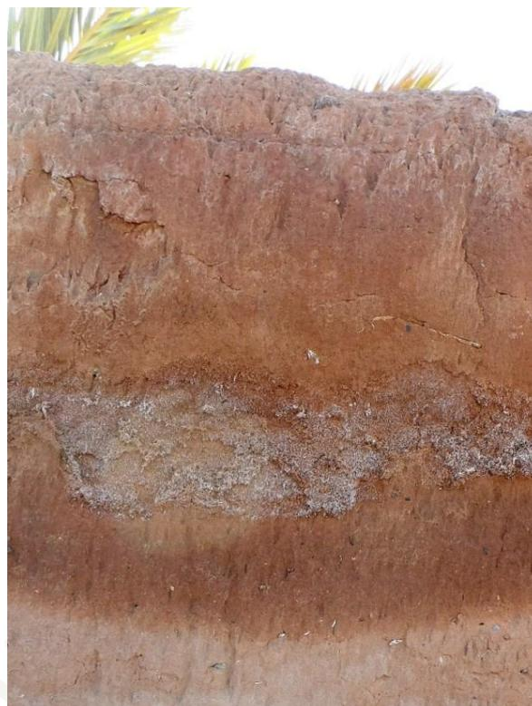
Salpêtre en partie haute d'un mur de clôture. Terre de construction souillée + eau salée
