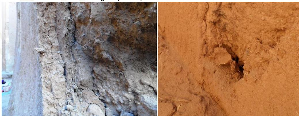
Erreur : couche d'enduit de corps fibrée utilisée pour reboucher les trous : Ouarzazatte (partie courante d'un mur), Tinzouline (pied de mur)
