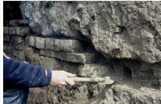
Principe de réparation d'une cavité à l'aide de briques
