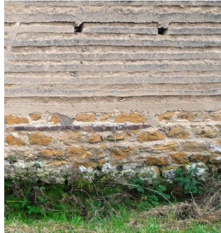
Soubassement en pierres hourdées au béton de chaux
