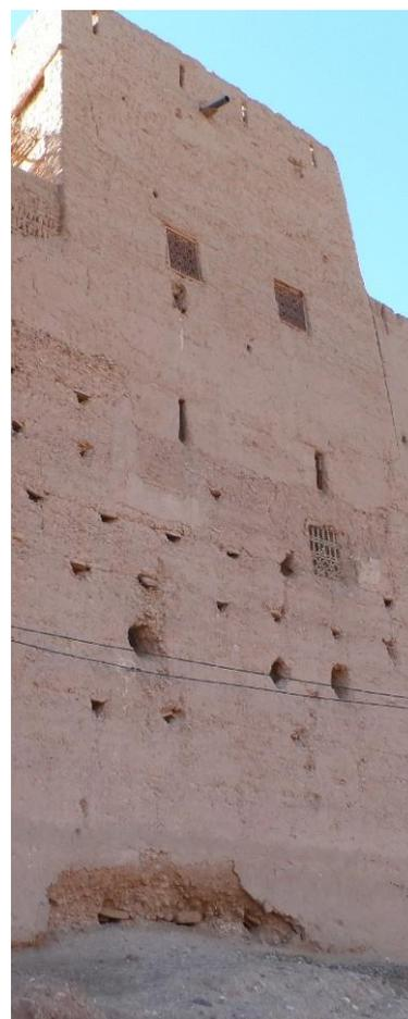
Evacuation d'eau d'une toiture terrasse et effet en pied de mur
