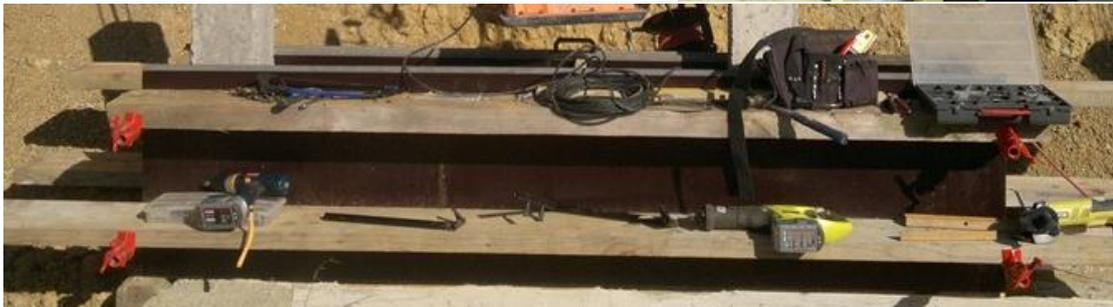
Un filetage doit être peut-être être réalisé sur une des extrémités du tuyau traversant, suivant les modèles. Entre les 2 panneaux de coffrage, on peut insérer un deuxième tube métallique autour du tube traversant, en guise d'entretoise.
