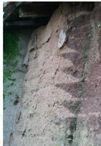
Stabilisation de surface en sapin de Noël (visible sur un mur en mauvais état)
