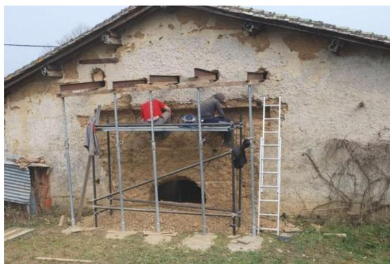
Étayage d'un mur en pisé, décroûtage et percement du linteau côté extérieur
