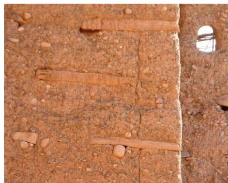
Palmier pour raccorder les banches dans les angles
