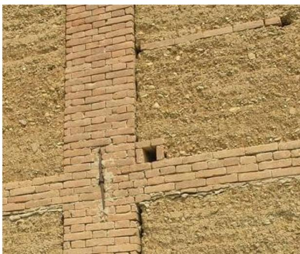
Pisé en remplissage d'une ossature en briques de terre cuite
