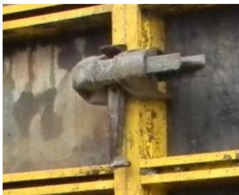
*Sangler le coffrage pour se faciliter la vie et limiter le nombre de serre-joints ou par manque de serre-joints n'est pas suffisant. Les sangles, même tendues conservent un peu d'élasticité, et la pression exercée par le damage suffit à écarter le coffrage.*
