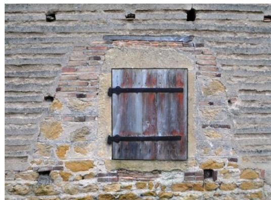
Fenêtre dans un mur en pisé d'un bâtiment agricole : pierre + brique cuite + tuiles + bois
