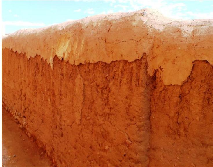
Mur coiffé en partie haute du mur par un enduit stabilisé, érosion juste au dessous
