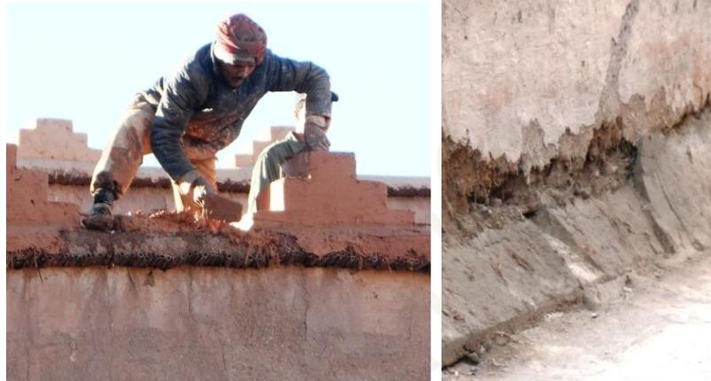
Débord de toit insuffisant sur mur en pisé présentant du fruit, conséquences en pied de mur
