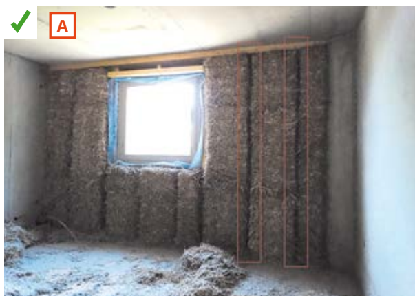
Diminution de la profondeur des montants. ©AQC-2015
