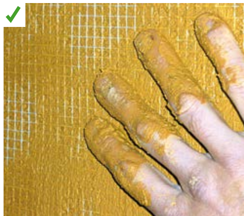
Mise en œuvre du support d'enduit terre avec toile de jute. ©Argilus
