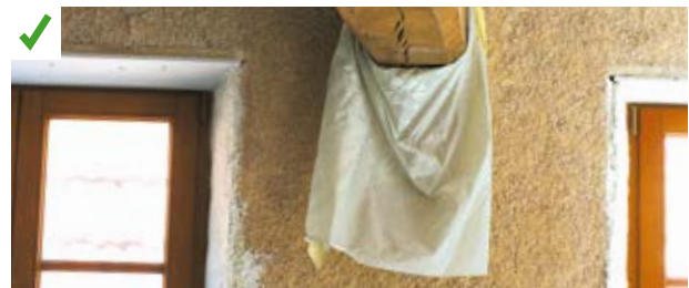
Couverture du bois apparent avec un plastique lors d'un remplissage en béton de chanvre. ©AQC-2015
