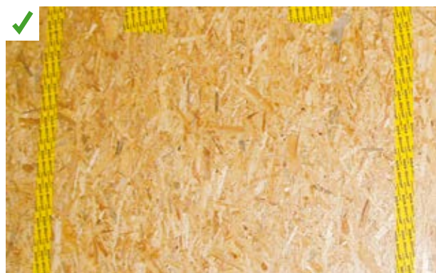
Étanchéité à l'air du bâtiment réalisée par les contreventements. ©AQC-2015
