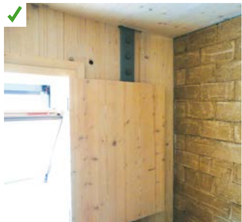
Exposition de la paroi en brique de terre crue (avant finition avec un enduit terre) aux rayons solaires en hiver. ©AQC-2015
