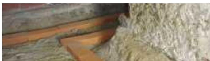
Pente à 45° non décaissée au pied du mur en pierre, et réseau de briques.
