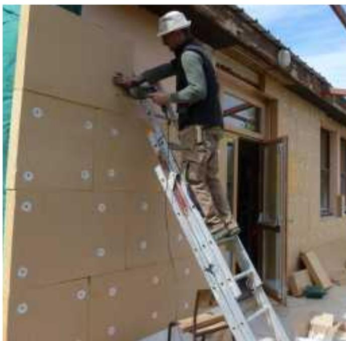
Fixation des panneaux de fibres de bois.
