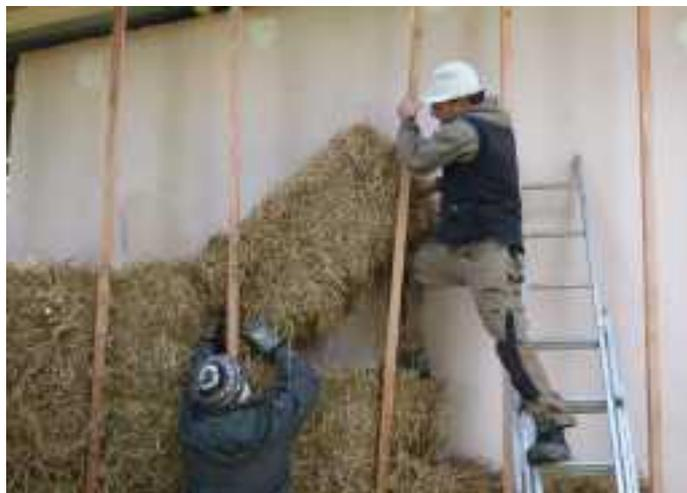
Mise en place des bottes de paille entre le mur et l'ossature.
