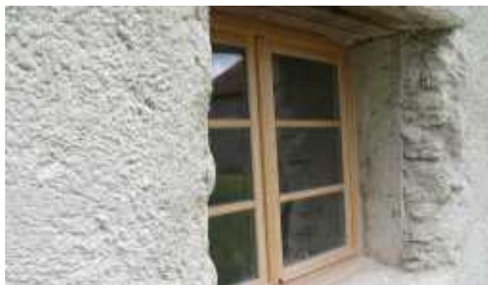
*Enduit extérieur, finition enduit chaux aérienne-sable.*
