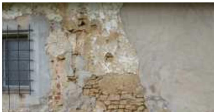
*Mur de galets et enduits dégradés par l'humidité.*
