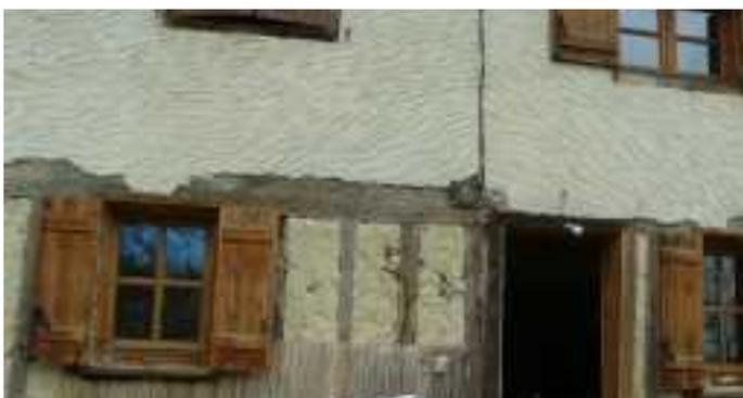
Enduit ciment recouvrant un mur en terre.
