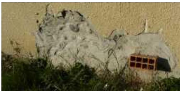
L'entrée du réseau de ventilation, côté est. La brique sera coupée au ras du mur lorsque les enduits seront piqués.
