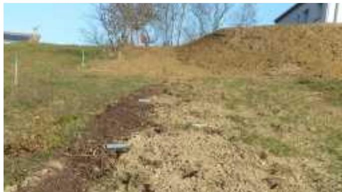
Vue depuis le bas du système avant recouvrement des tuyaux par les tuiles canal : les tuyaux arrivent au-dessus des tranchées remplies de BRF.
