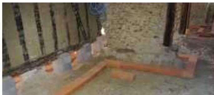
Le réseau passe le long des murs et au milieu de la pièce. Des briques coupées à 45° forment les angles.
