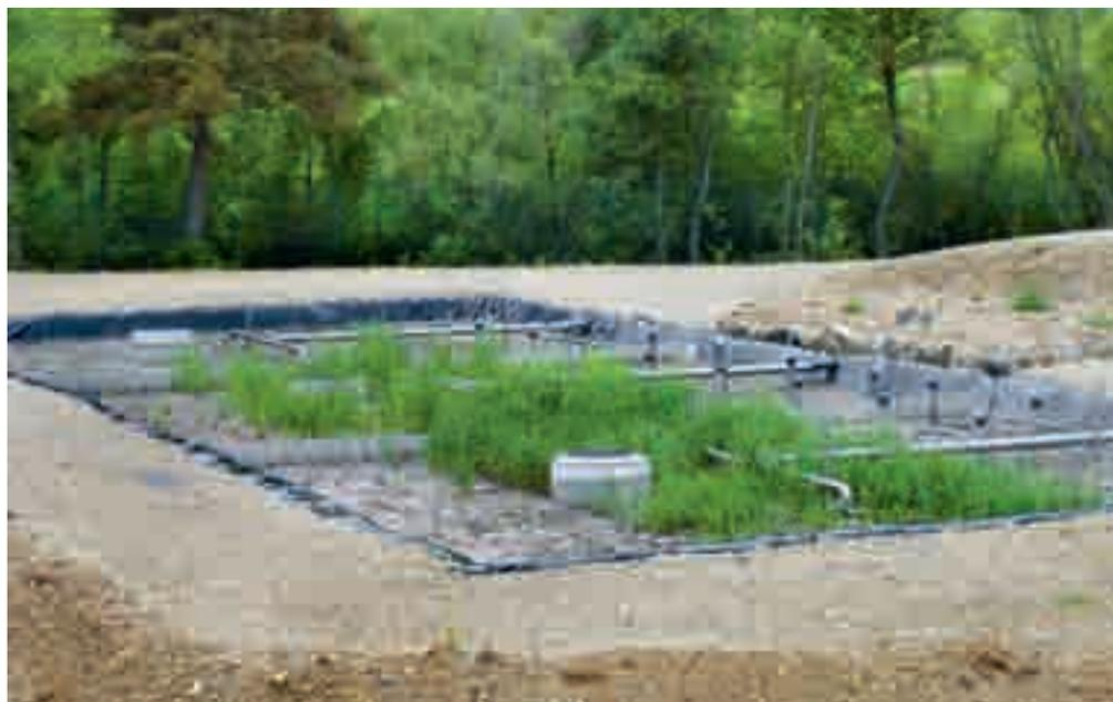
Filtre vertical planté de roseaux de la station d'épuration d'une commune des Alpes-de-Haute-Provence.
