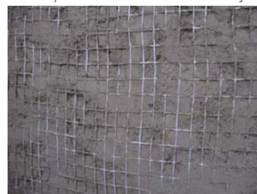
5. Maçonnerie ancienne de pierre préparée avec crépi de **REABILITA CAL Consolidação**
