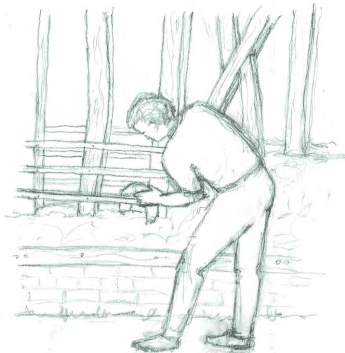
**Illustration 28: Pose à cheval :** Mise en œuvre sur tout support de fixation suffisamment résistant et espacé pour recevoir une paumée de torchis à cheval. Les poignées se superposent les unes aux autres. Les deux parements peuvent être dressés en même temps par un travail en vis à vis qui nécessite deux poseurs, parfois une banche fixée provisoirement remplace un poseur.
